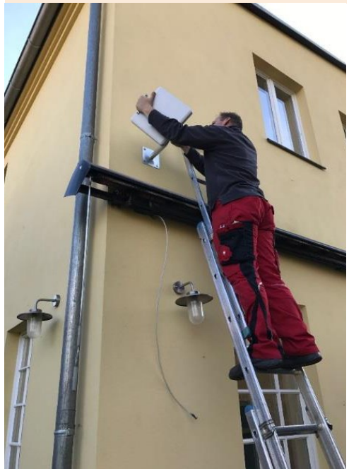
LTE Endgerät LTH (LTE to the home) und seine Montage in Schlabendorf, Quelle: Nokia
